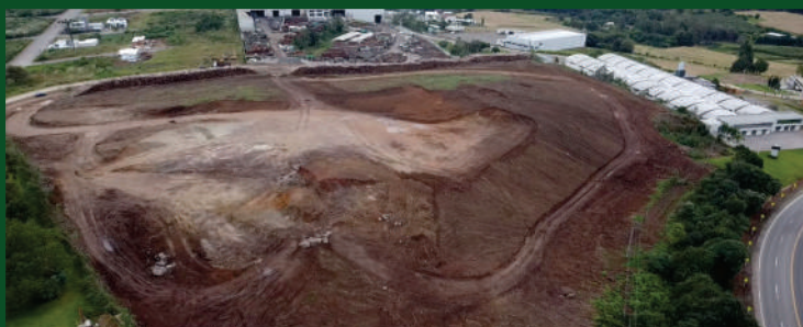
Futuras Instalações - Nova Milano - Farroupilha - RS
