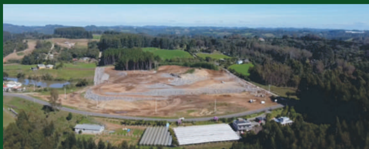
Futuras Instalações - Nova Sardenha - Farroupilha - RS
