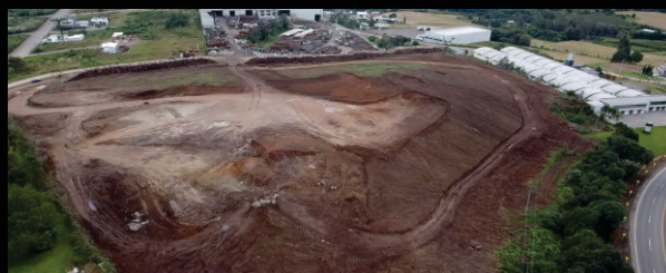
Futuras Instalações - Nova Milano - Farroupilha - RS
