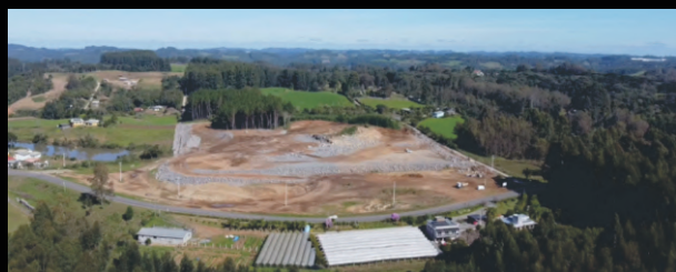
Futuras Instalações - Nova Sardenha - Farroupilha - RS
